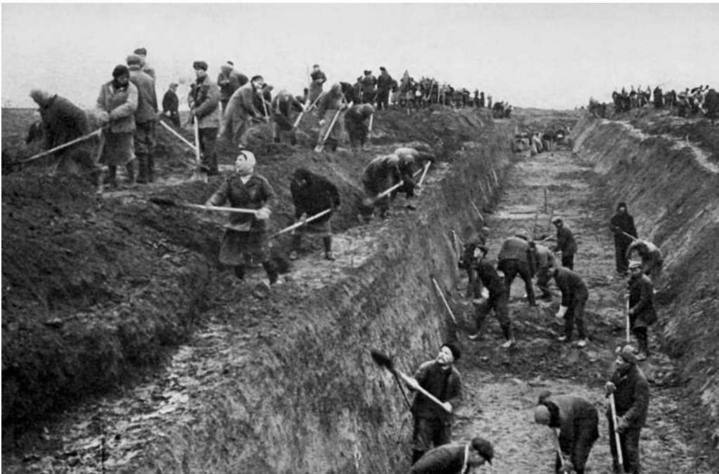
Строительство оборонительных сооружений под Москвой. Осень 1941 г.
